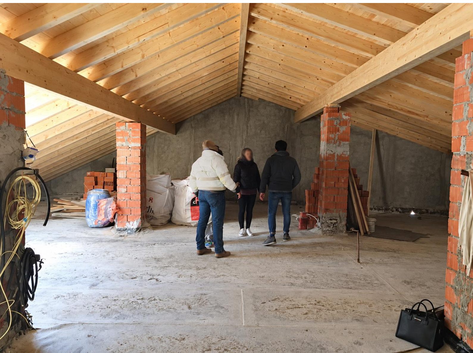
Primo sopralluogo in cantiere
